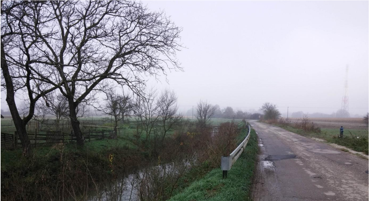
Slika 1.1-2. Kanali uz cestu
